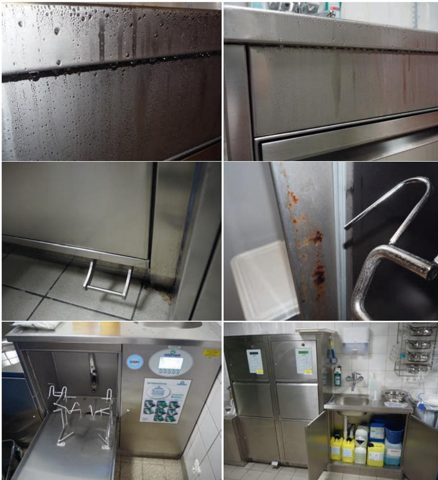
**Abb. 6:** Steckbeckenspülgerät mit Kondensat Austritt während der Desinfektionsphase, abtropfendes Kondensat, Verschmutzungen rund um die undichte Türdichtung außerhalb des Innenraums und Gesamtaufnahmen. Man beachte den Fußschalter.
