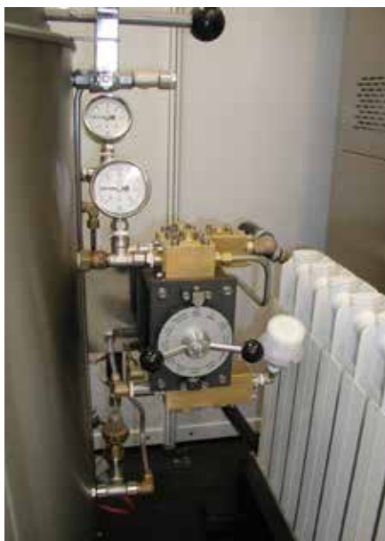
Fig. 2: Esquerda: Um protótipo de segunda geração da autoclave instalado num hospital regional em Eikwe, Gana.
